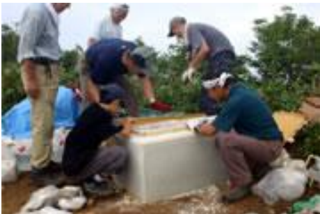
仮枠解体後表面研磨中
